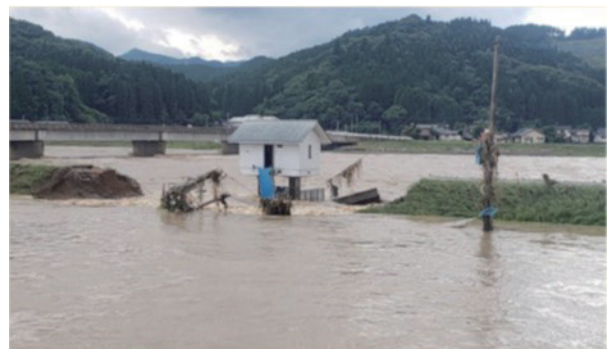
令和2年7月豪雨による被害 (球磨川の堤防決壊)
