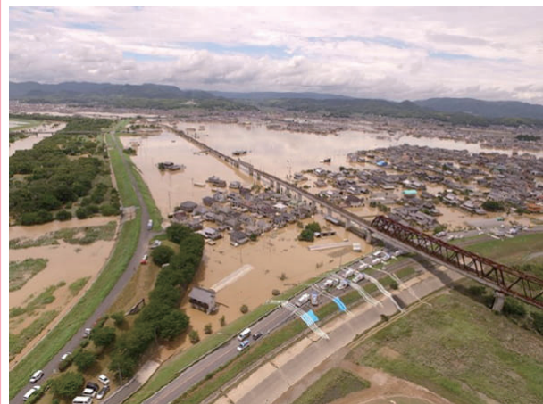
図表 I -1-1-22 平成30年7月豪雨による被害 (岡山県倉敷市真備町の浸水状況)
