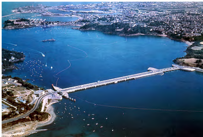
図 2.2.18 ランス潮汐発電所(フランス)
