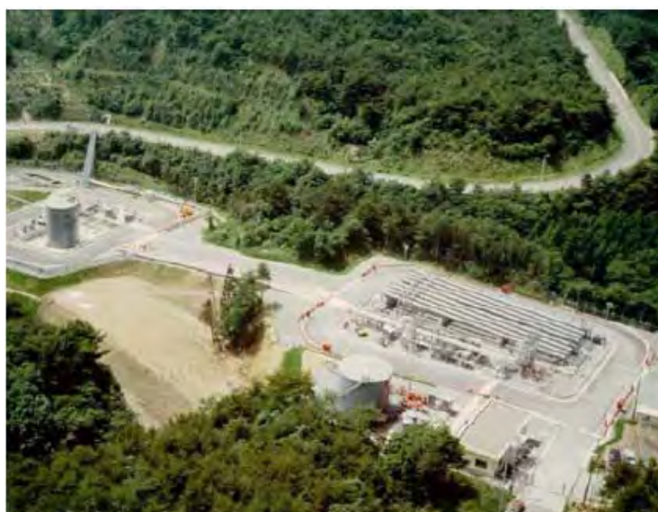
図3.2.23 磐城沖ガス田の陸上プラント （出典：「中央鉱山保安協議会石油鉱山保安部会（第7回）資料 2007年」経済産業省）
