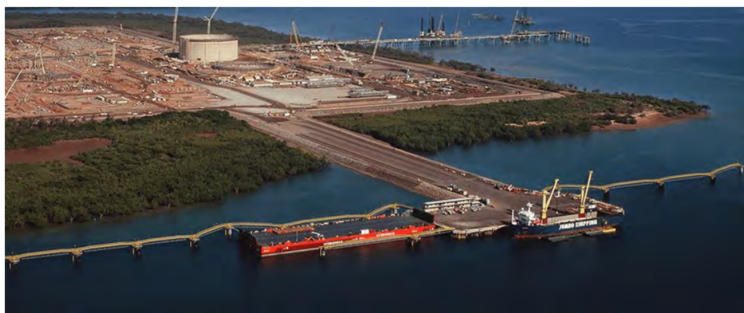
図 3.2.2 イクシスLNGプロジェクト
