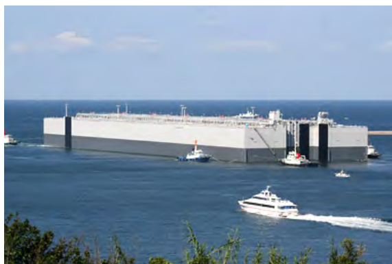
(上五島国家石油備蓄基地)
