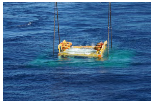
図3.2.15 生産マニホールドの設置作業
