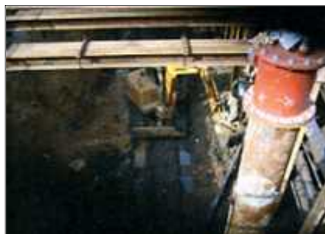
SWP 工法による掘削現場 (韓国)
