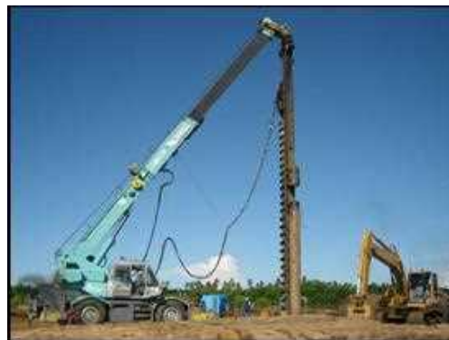
杭基礎工事 (ガイアナ共和国)
