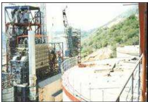
セメントプラント全工場設備工事 (ジャマイカ)
