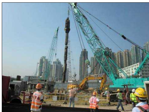
既存杭撤去工事（香港）
