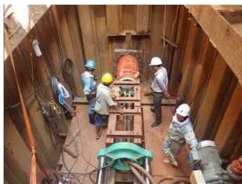
推進工事の様子
