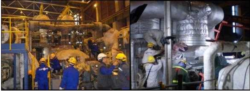
発電所定期点検改造工事（香港）
