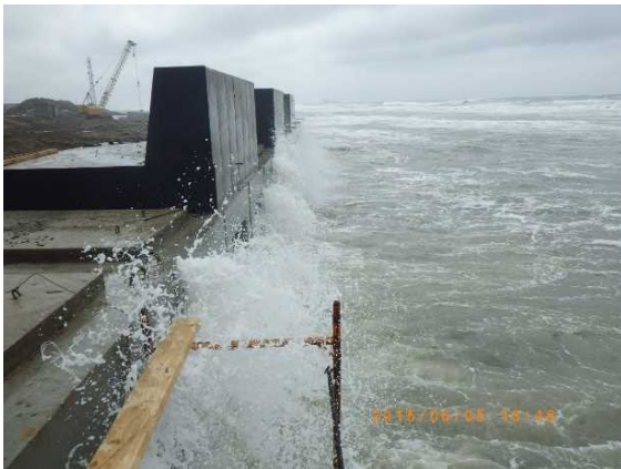
H27 施工途中の時化状況 L=250m
