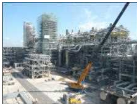
石油化学プラント建設工事（東南アジア）
