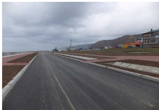
H27 護岸部完成 L=250m
