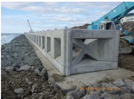
H27 ネプチューン設置完了 L=250m
