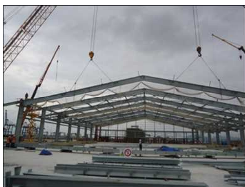
コンテナ・ターミナルポートコンテナ倉庫工事（ベトナム）
