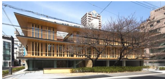
某オフィスビル(大阪) 2012年7月着工
