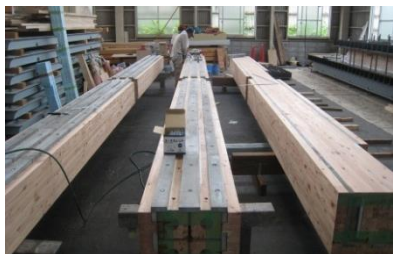
①モルタルバー取り付け
