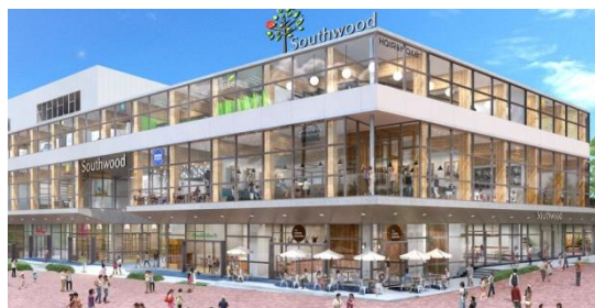
某商業施設(横浜) 2012年7月着工
