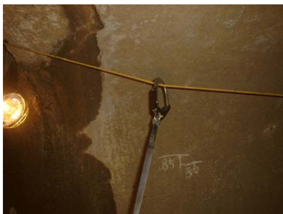
親綱設置状況
