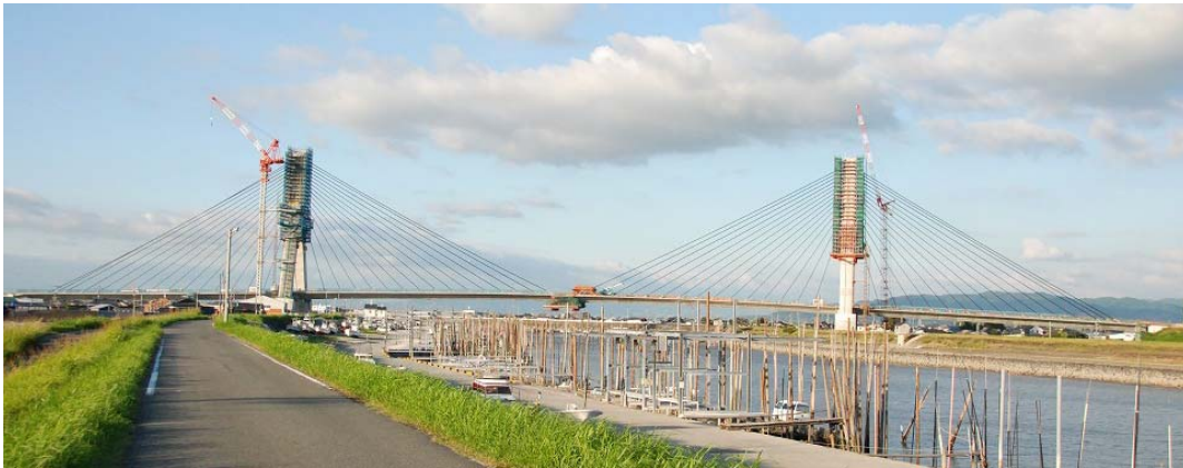
写真-9 矢部川橋建設状況
