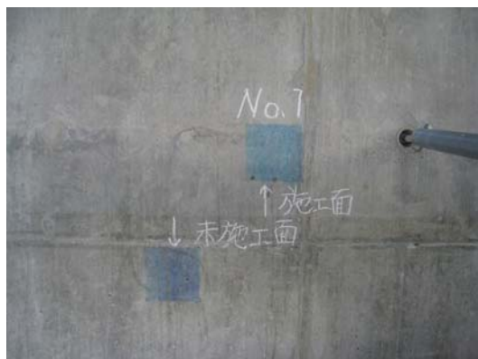
写真-10 メチレンブルーによる防汚性能確認状況(施工直後)
