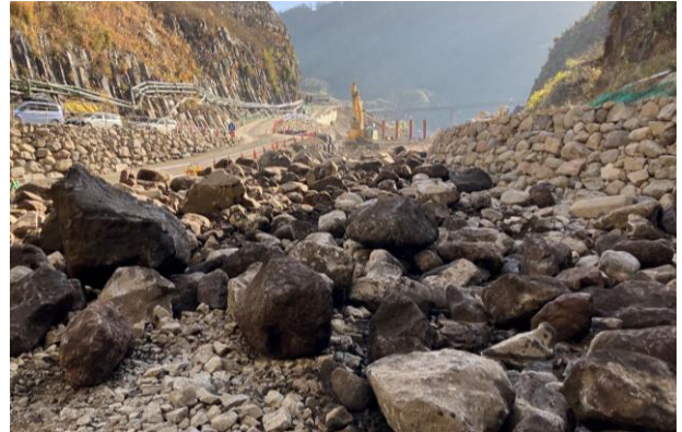
図-17 巨円レキの投入状況
