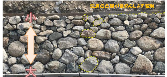
図-7 安定したイメージを与える護岸（施工事例）
