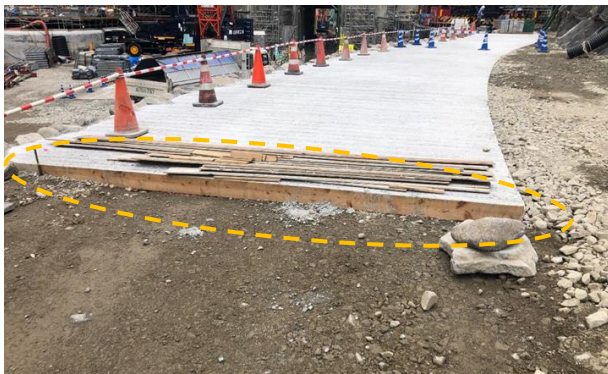
図-16 杉板を使用した張コンクリートの目地
