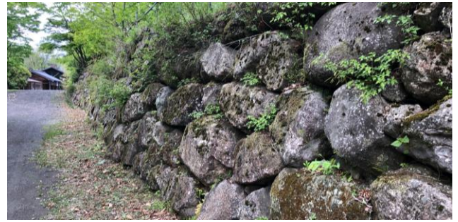
図-6 レキ間に植物が生え自然なじむ護岸（施工事例）
