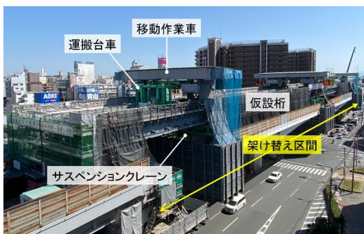
写真-6 仮設桁への撤去用設備設置後の状況
