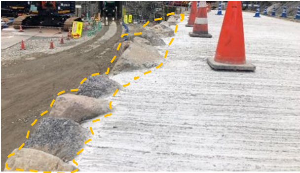
図-14 石積のレキが突き出した自然な天端の仕上がり
