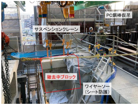
写真-7 既設橋梁の撤去状況
