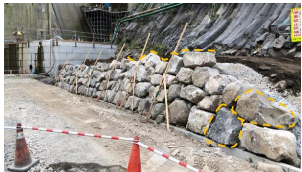
図-13 大小の異なる石で凹凸に噛み合わせた状況
