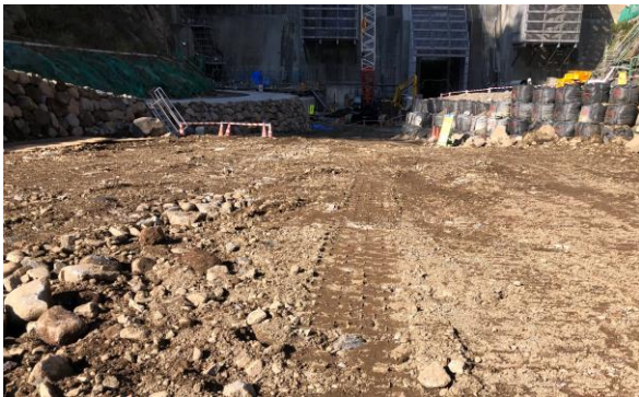
図-9 工事発生土が堆積した河床
