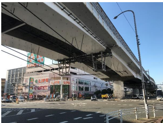
写真-1 更新前の喜連瓜破橋（2022年4月）
