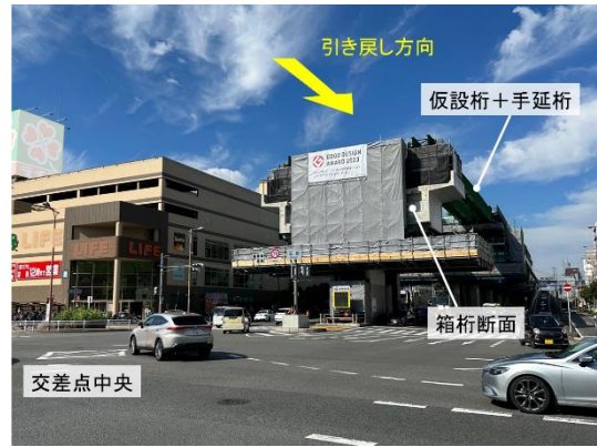
写真-8 仮設桁引き戻し状況（箱桁撤去完了後）
