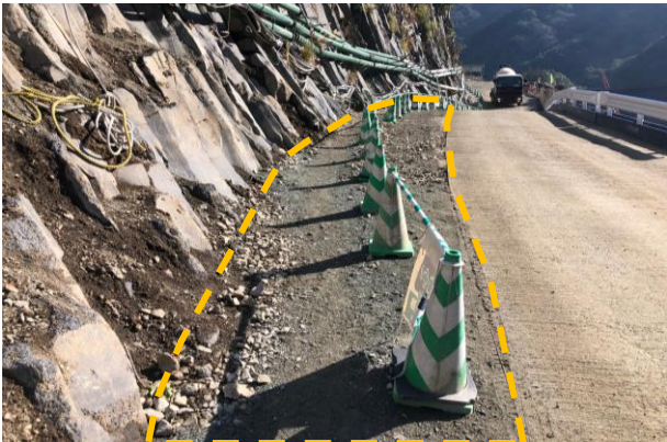
図-15 セメント改良土で自然な仕上がりとなった舗装面
