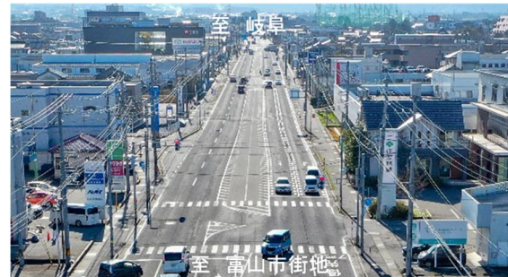
写真-1 黒崎電線共同溝PFI事業箇所の状況
