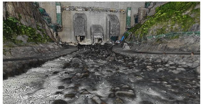
図-22 UAV測量による3次元点群データの作成
