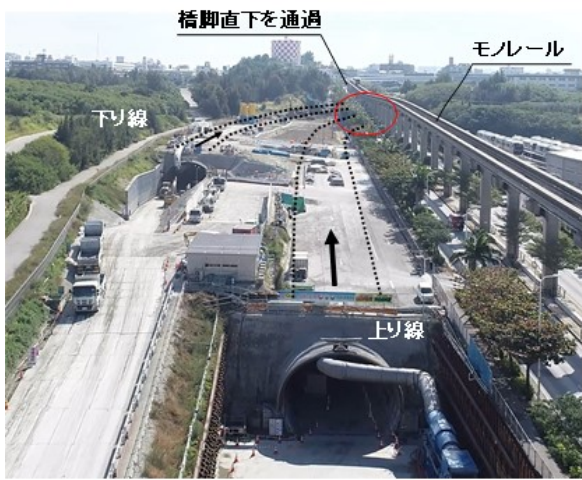
写真-1 モノレール直下横断図
