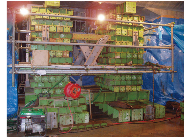
上越新幹線 RC高架橋支柱緊急復旧対策
