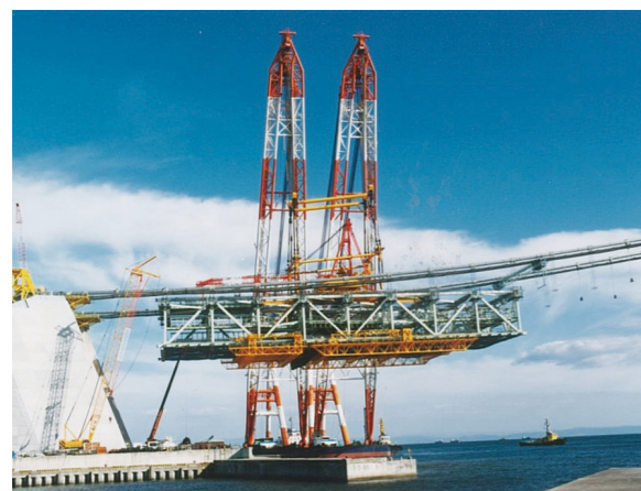
明石海峡大橋補剛桁大ブロック架設
