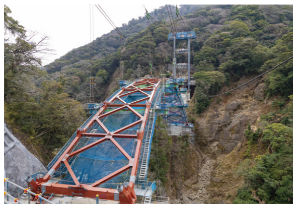
ケーブルクレーン架設
