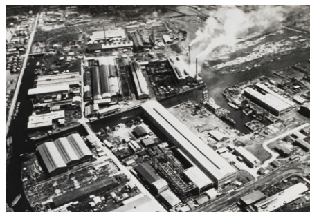
砂町第1・第2工場
