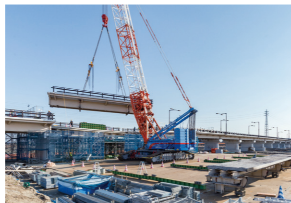
クローラークレーンによる撤去
