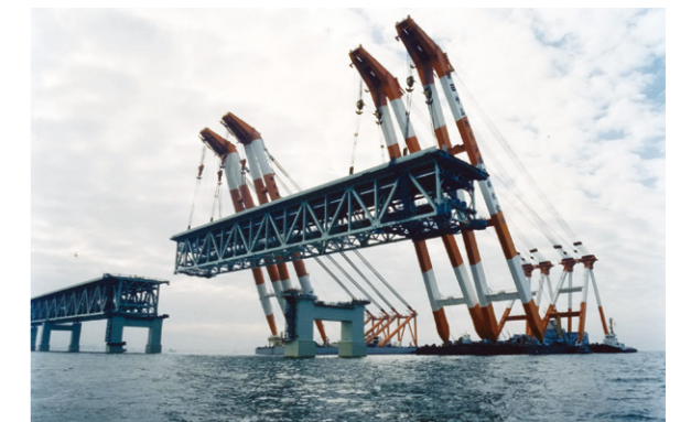
大型FCによる大ブロック一括架設
