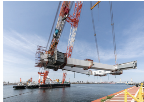
大型FCによる主塔浜出し
