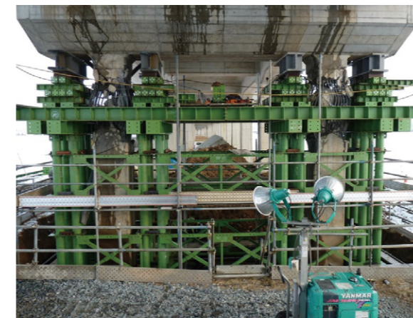
東北新幹線 RC高架橋支柱緊急復旧対策
