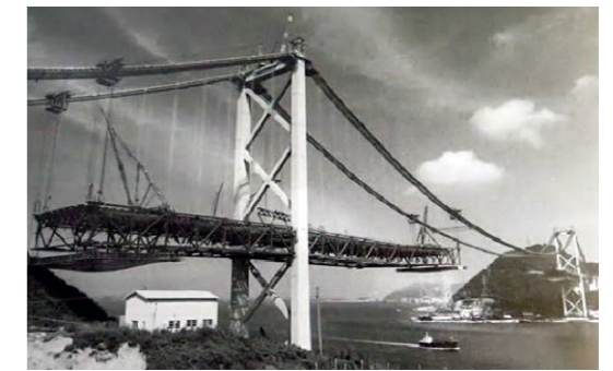
架設中の関門橋
