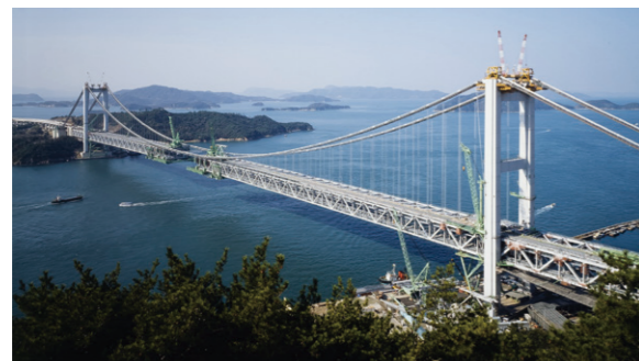
架設中の下津井瀬戸大橋
