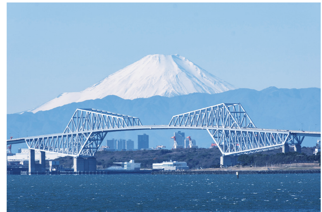
東京ゲートブリッジ
