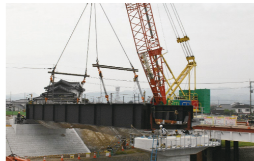
クローラークレーンによる一括架設
