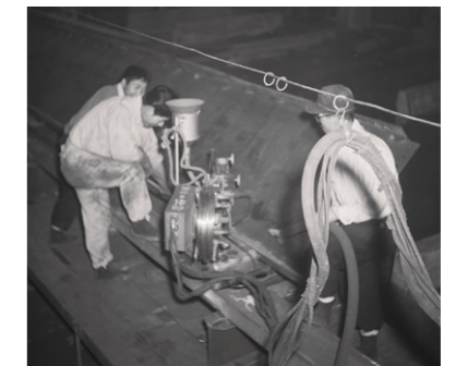
波田工場での作業の様子
