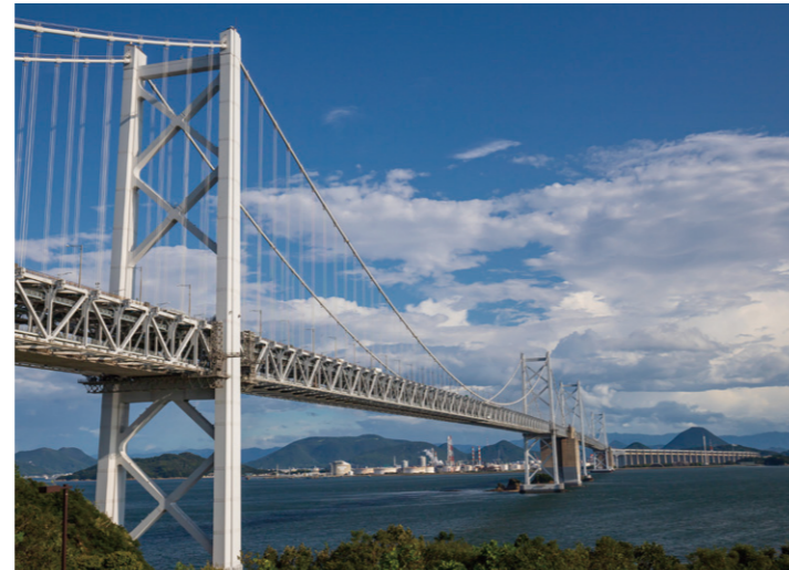
北備讃瀬戸大橋(手前)・南備讃瀬戸大橋(奥)
