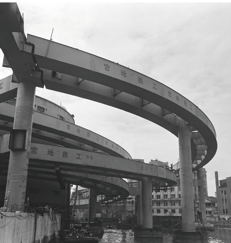
建設中の江戸橋ジャンクション
