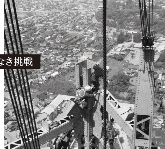
東京タワー建築作業の様子
