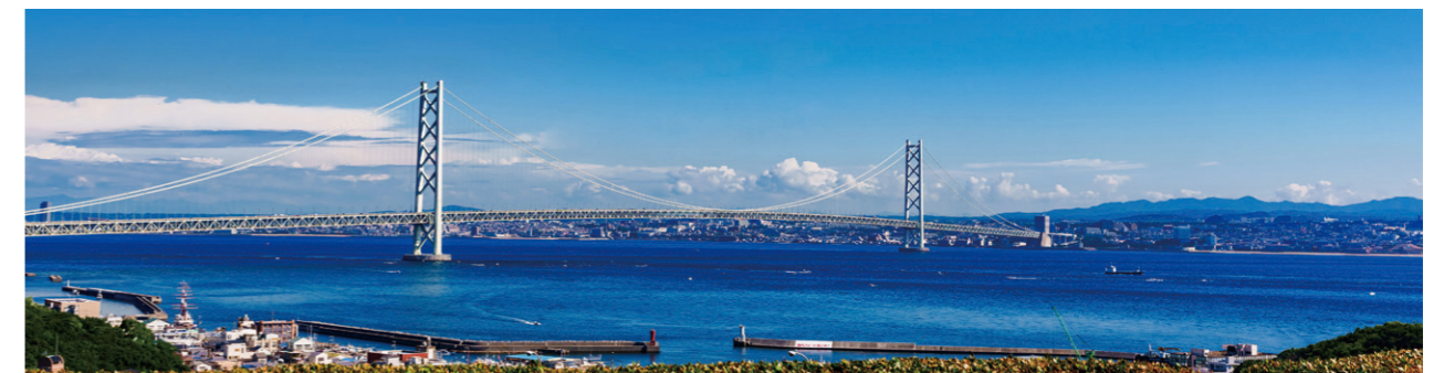
明石海峡大橋
