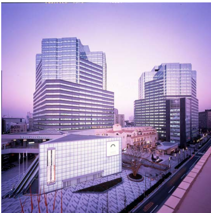
大崎駅側からの全景（竣工当時）
