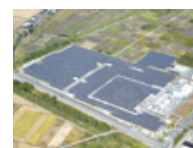
三井不動産 大牟田 太陽光発電所
