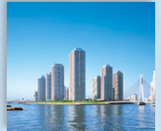
大川端リバーシティ21 西ブロック 1993年全体竣工
