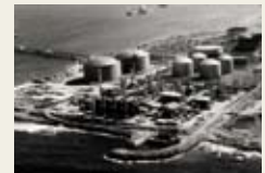
アブダビ・ガス島 LNG 開発
