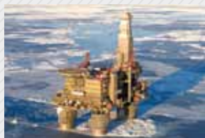
サハリンII 海上掘削・生産設備 © Sakhalin Energy Investment Company Ltd.
