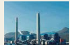
パイトン火力発電所（インドネシア）
