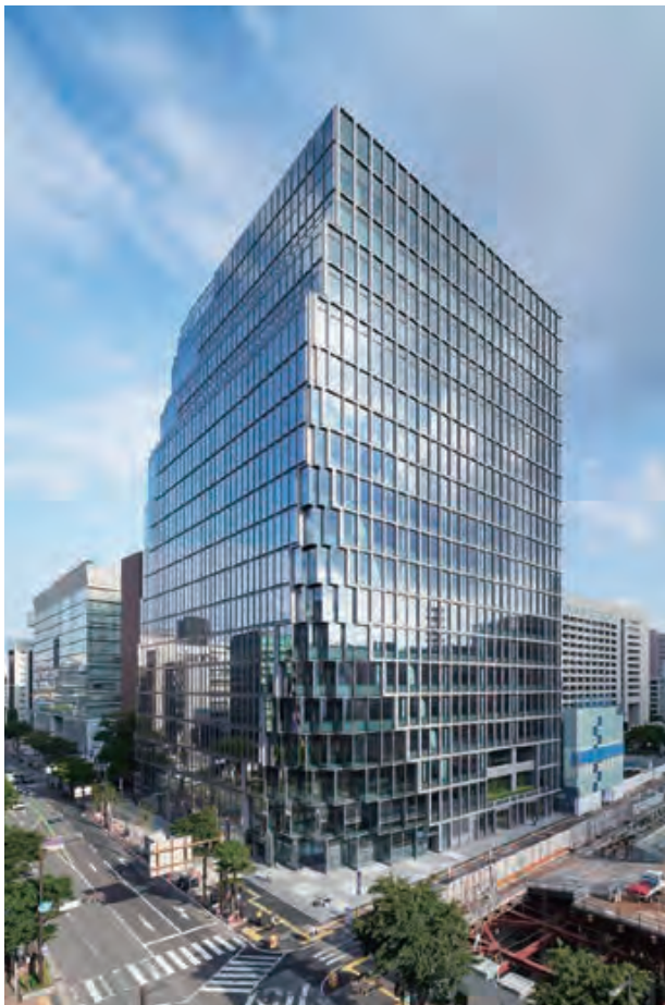
天神ビジネスセンター：北西側外観
