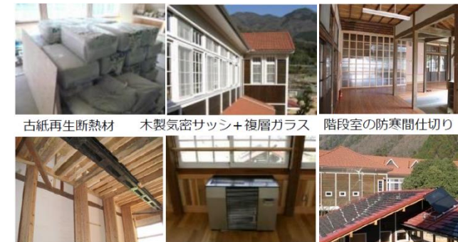
木造校舎耐震改修
