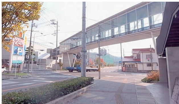
離れた敷地をつなぐ連絡通路。交差点を安全に渡ることができる。
