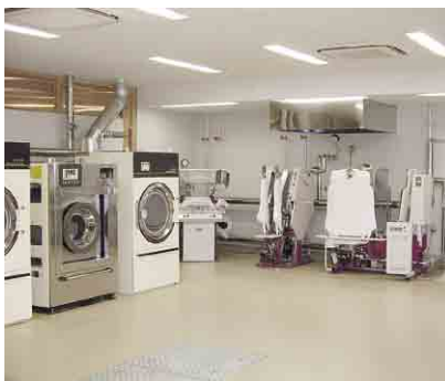
⑩ クリーニング室には、業務用の洗濯機材のほか、接客カウンターも設置しており、クリーニング店の業務を一通り実践することができる。水の使用を考慮して、床は防水の仕様になっている。
