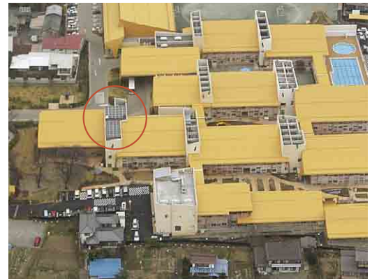
⑬ 屋根に設置された太陽光パネル、発電容量は10kW。
