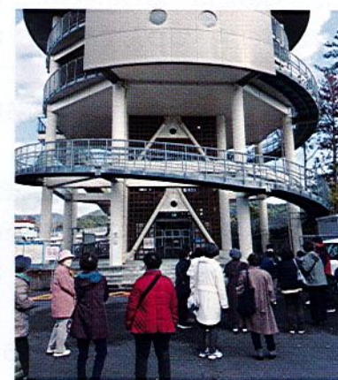
第1号津波避難タワー
