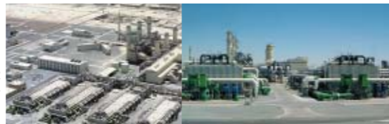
タウィーラA2 発電造水プラント
