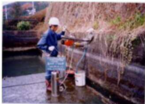
施設の機能診断
