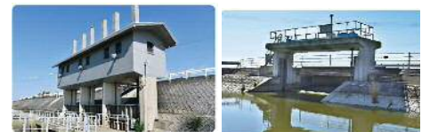
用排水路の整備と併せて排水樋門や制水門等も整備
