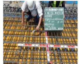
工事の監督・検査
