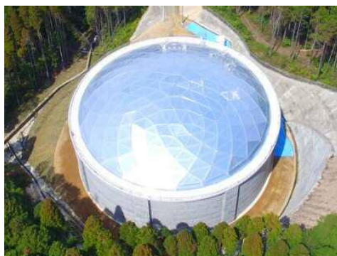
鹿屋ファームポンド(容量9,105m 3 、直径40.9m、高さ12.5m)
