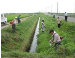
水路両岸の草刈り
