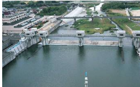
川上頭首工（可動堰型式、堰長178m、取水量Qmax 19m 3 /s）
