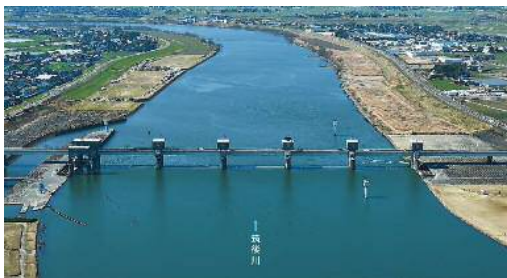
筑後大堰（可動堰型式、堰長500m、取水量Qmax 左岸側13.5m 3 /s、右岸側18.6m 3 ）
