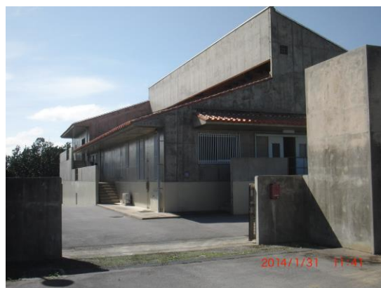
農業集落排水処理施設（宮良・白保地区）
