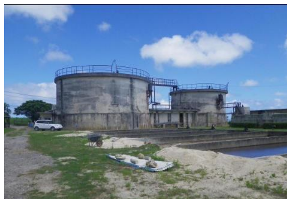
石垣市し尿処理場
