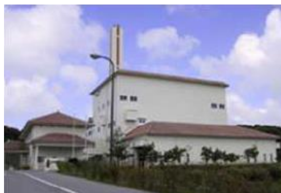
石垣市クリーンセンター
