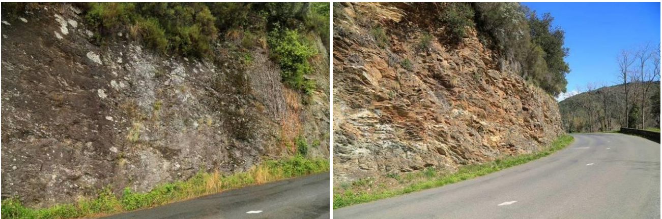
Aspect des talus rocheux (front de taille) bordant la RD984
