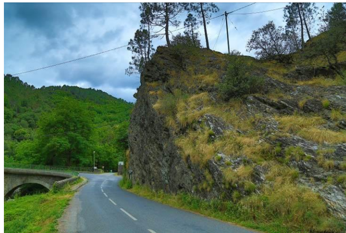
Secteur où une purge préventive de falaise est envisagée
