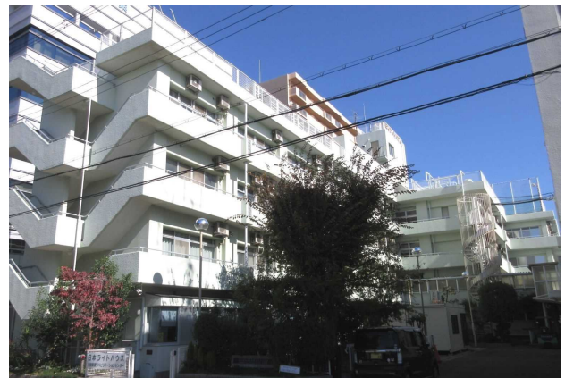
改修前のリハビリテーションセンター東西館
