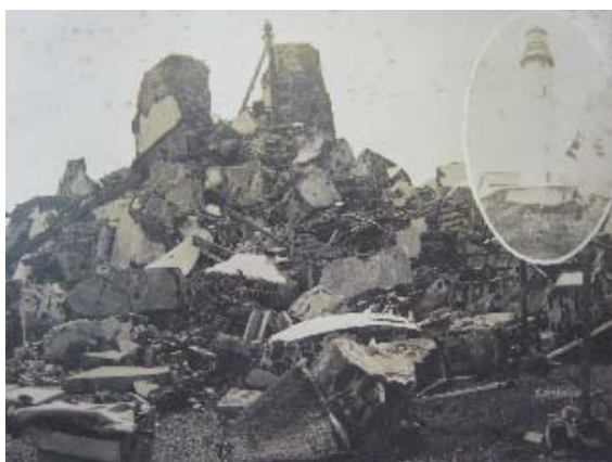
野島崎灯台（白浜村）崩壊の状況（現在の南房総市）
