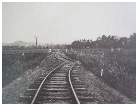
鉄道線路被害の状況
