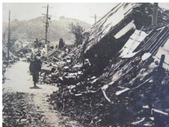
家屋倒壊の状況（館山町 現在の館山市） 館山町も海底の砂地だったところが隆起し、そこに家々が立地しているところが多く、多くの家屋が倒壊した。総戸数1,678軒のうち1,455軒が全壊した。死亡者も116人を数えた。
