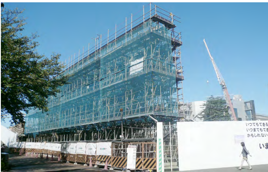
工事風景：ガラス・ハウス組立て
