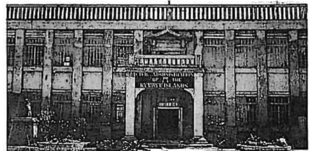
米国民政府庁舎玄関（現在の上山中学校跡）
