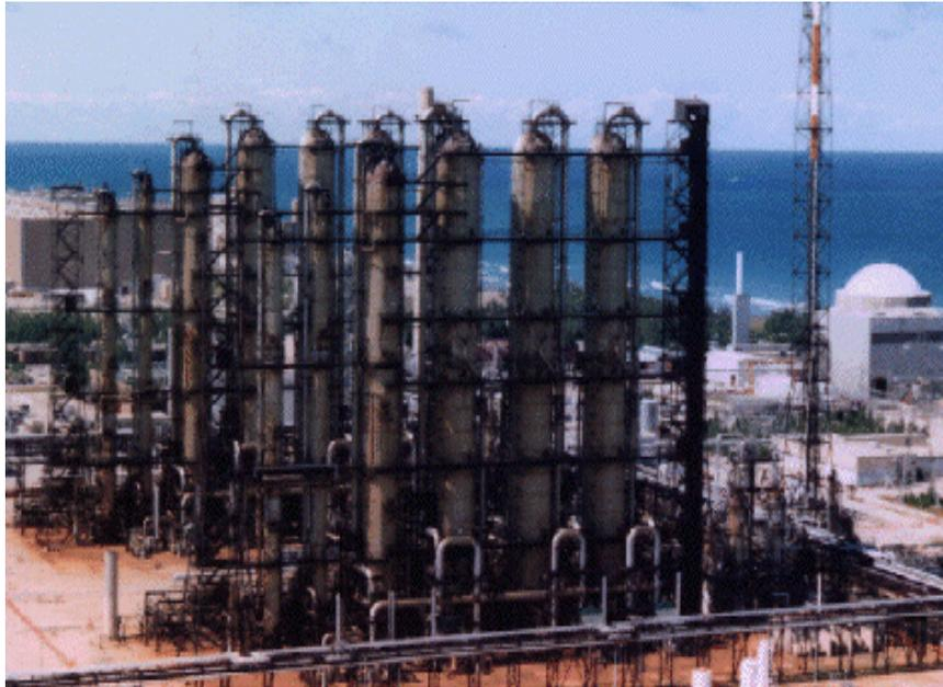
图2.6. 安大略国际水电公司年产800吨的布鲁斯点（Bruce Point）重水工厂，该工厂已于1997年关闭，八个这种规模工厂提供的重水即可满足如今全世界的能源消耗。
