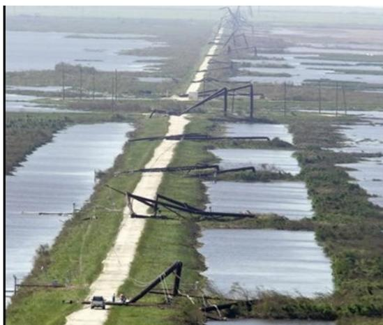
图14.1. 2004年佛罗里达州风暴摧毁的输电线路，输变线路是电力公司的致命弱点。
