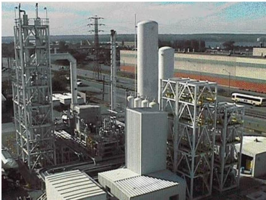
图2.7. 加拿大安大略省汉密尔顿（Hamilton）的加拿大原子能公司先进的重水中试装置，该公司供图。其中试装置每年生产约1吨重水，规模化后比前图所示的老布鲁斯点工厂更高效、更清洁。
