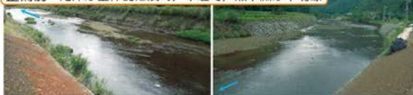
整備前→河床が全体的に浅く、平坦で、瀬や淵が不明瞭
