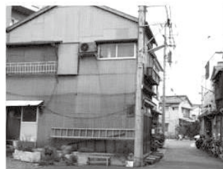
道路整備状況 整備前
