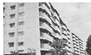
上宮川地区 改良住宅
