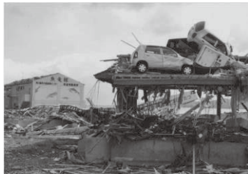
被災状況 (歌津地区)
