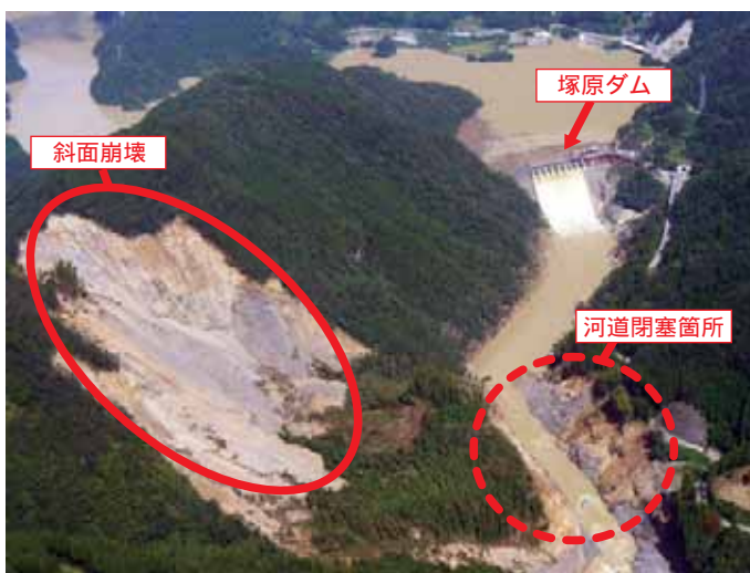
塚原ダム下流における斜面崩壊
