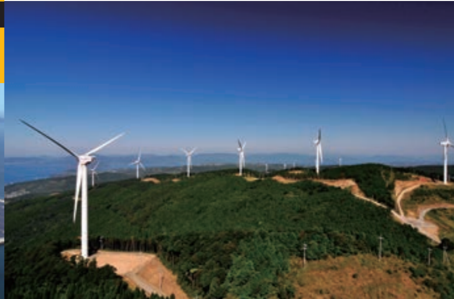
長島風力発電所
