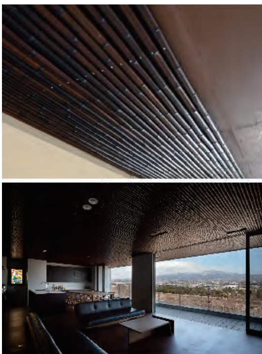
図6 天井に貼られていく煤竹と使用例
