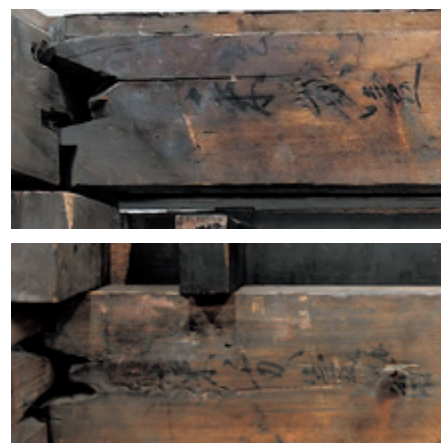
図12 上：南側上框東端部 下：南側土台東端部
