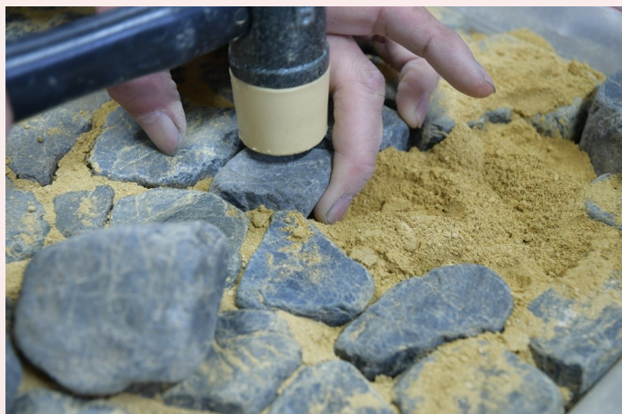
③ 石の打ち込み
