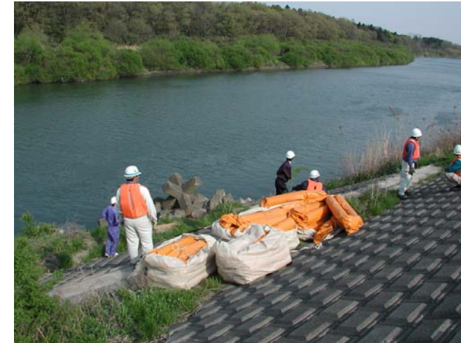
水質事故の状況 (オイルフェンスの設置)
