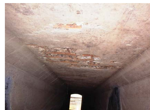
老朽化施設の増大 (施設点検状況、老朽樋管)
