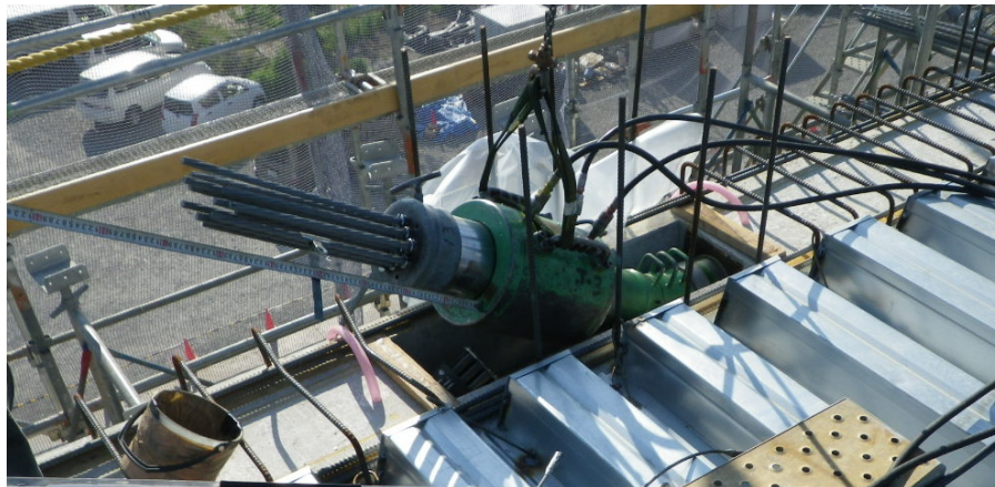
図表 7.4 カーブチェア使用の緊張状況と部品構成例
