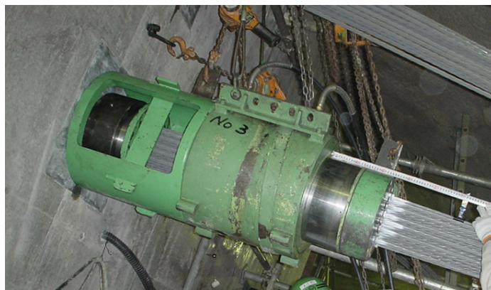
図表 7.2 F型チェア使用の緊張状況と部品構成例
