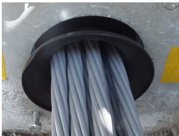
図 6.13 防食PC鋼より線の挿入状況
