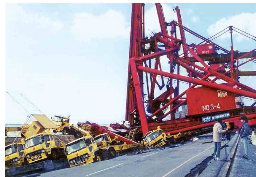
阪神・淡路大震災で被害を受けた埠頭とガントリークレーン (写真：日東物流)
