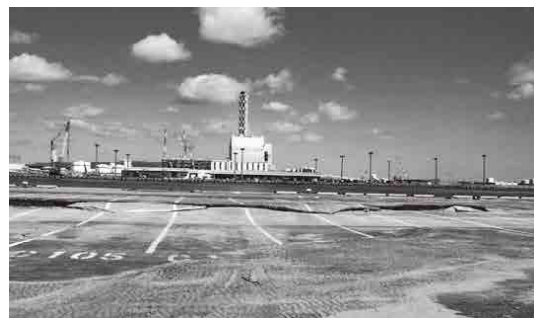
被災した常陸那珂港
