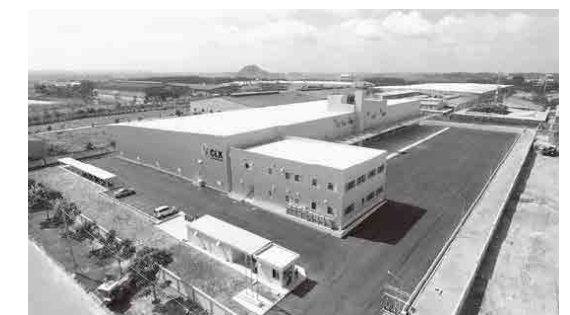
CLK COLD STRAGE
