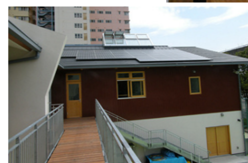
屋根の上の ソーラー発電パネル
