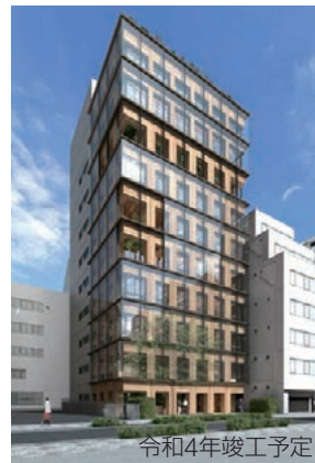
純木造11階建ての研修施設(OYプロジェクト、(株)大林組) 令和4年竣工予定
