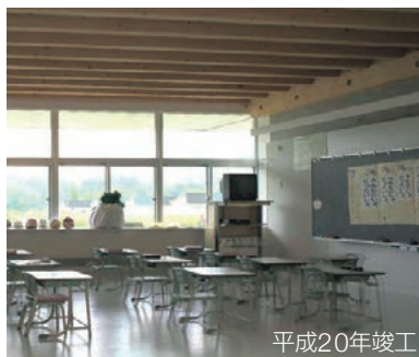
壁をRC造、床を木造とした混構造の小学校(糸魚小学校) 平成20年竣工
