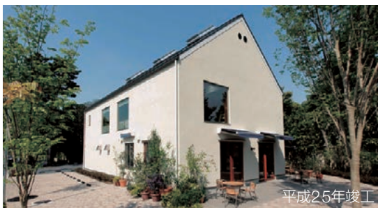
野菜倶楽部 oto no ha Café (オトノハカフェ) (東京都) 大臣認定を受けたメンブレン型耐火構造による建築例 平成25年竣工
