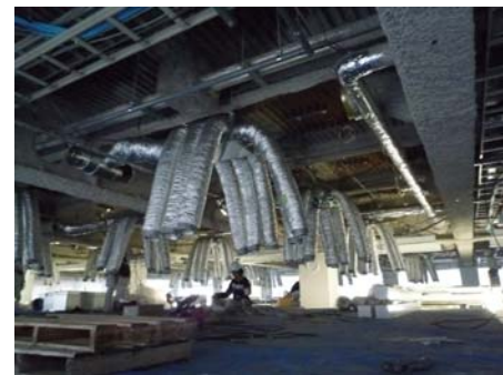
図4 改修工事 実施状況
