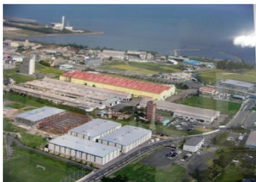
▲ 中津工場全景
