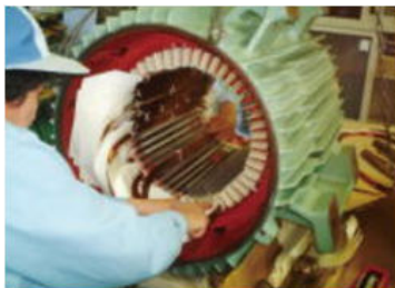
発電機・モーター点検・整備
