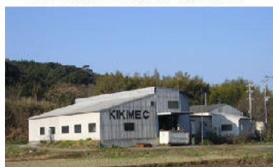
▲マシンセンター(敷地1,000㎡,工場600㎡)
