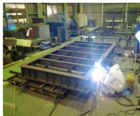
▲ 周辺機器等の製缶作業
