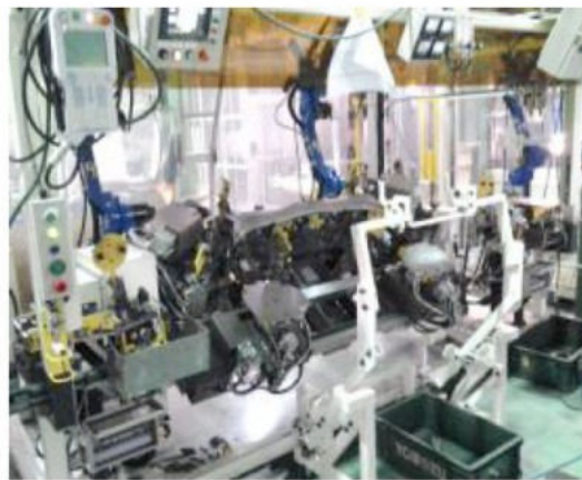
▲ アークロボット溶接装置
