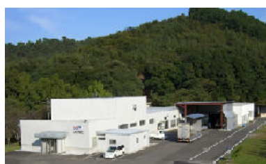
▲本社工場(敷地19,000㎡,工場1,800㎡)
