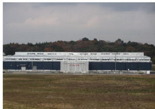
▲山宗(株)大分工場 2期工事完了 2016年12月
