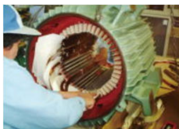
発電機・モーター点検・整備
