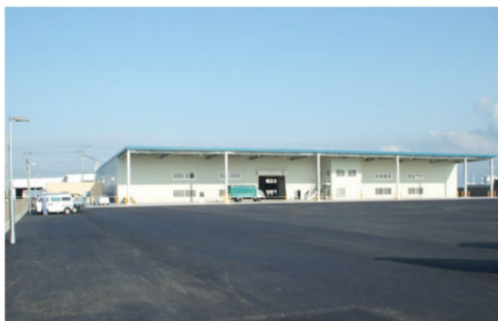
▲大分営業所 倉庫外観
