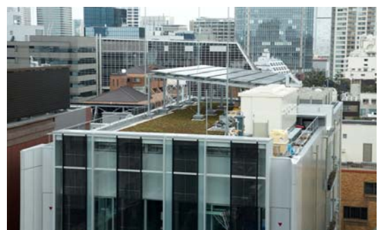
屋上の太陽光発電
