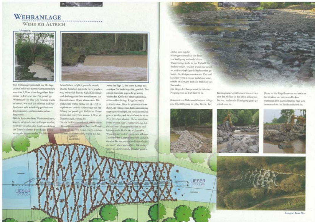
図 7.26 全面魚道タイプへの改築
