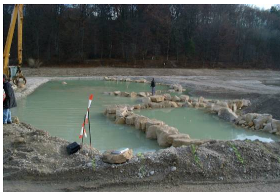
図 6.23 施工状況 (補助用堤防あり)
