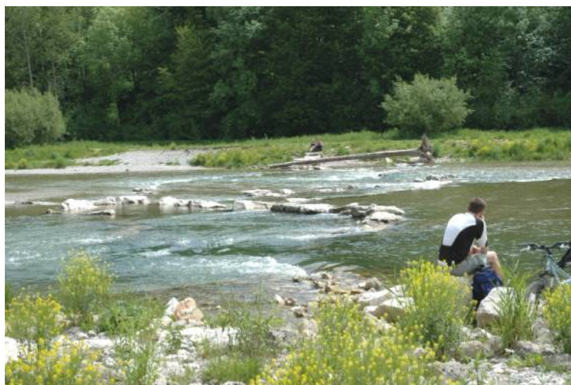
図 6.24 改修後の床止め
