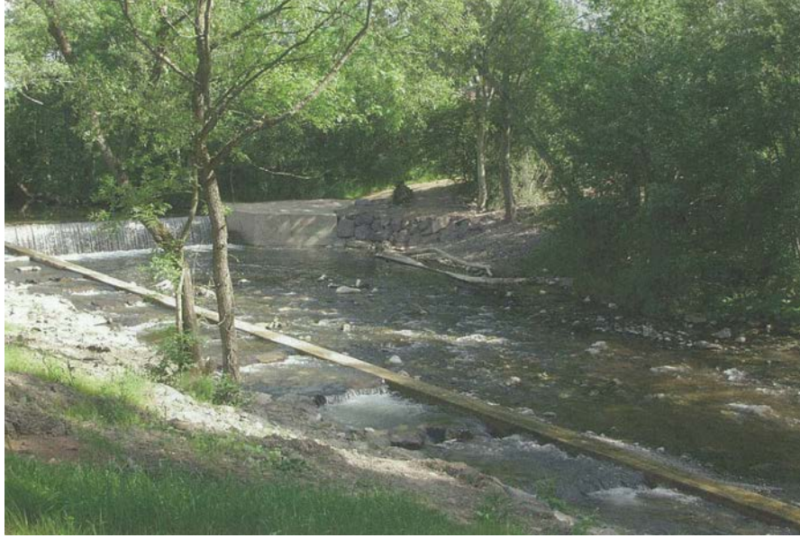
図 7.25 改築後の魚道
