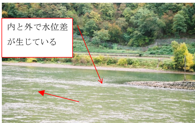
図 5.5 内と外で水位差が生じている
