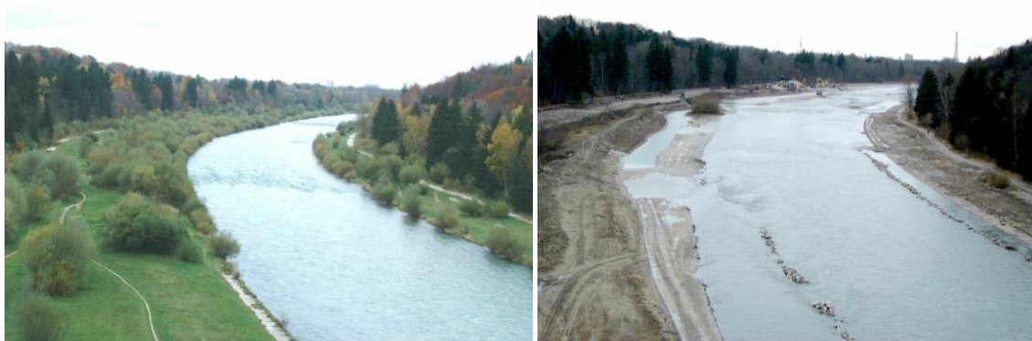
図 6.39 工事前(左)と工事中(右)の状況
