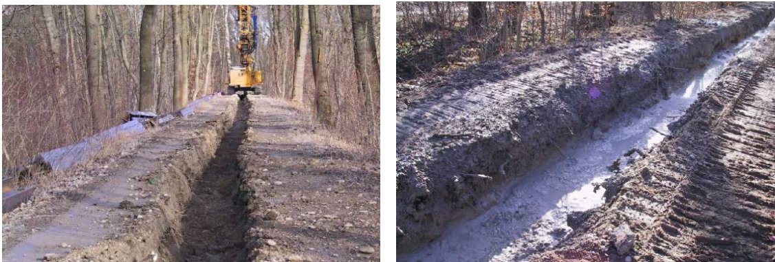
図 6.32 施工重機およびコンクリート打設状況
