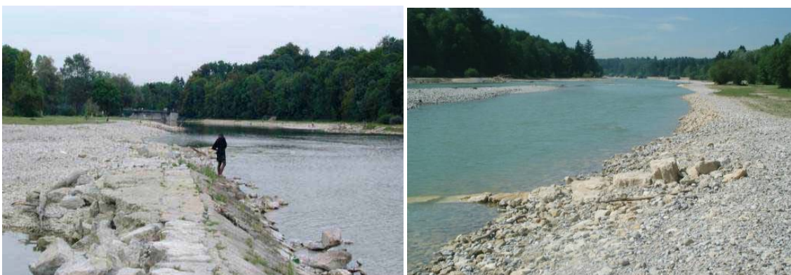
図 6.34 改修前(左)と改修後(右)状況
