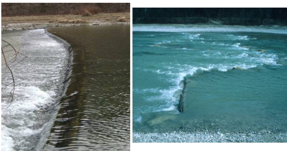
図 6.20 床止めの改修前(左)と改修後(右)
