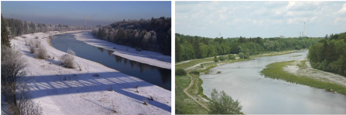
図 6.40 工事後の最初の冬(左)と春(右)の状況 左が第3工区の工事区域です。右が完成イメージになります。(図 6.41)
