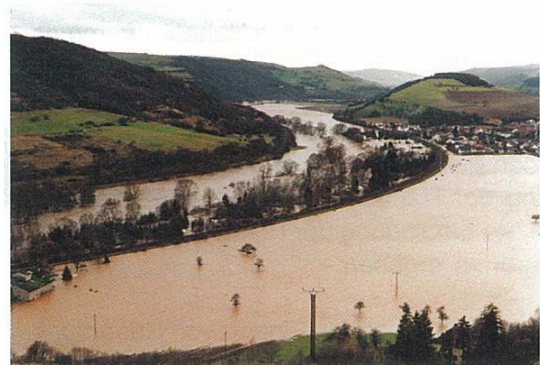
図 7.20 遊水地への流入状況
