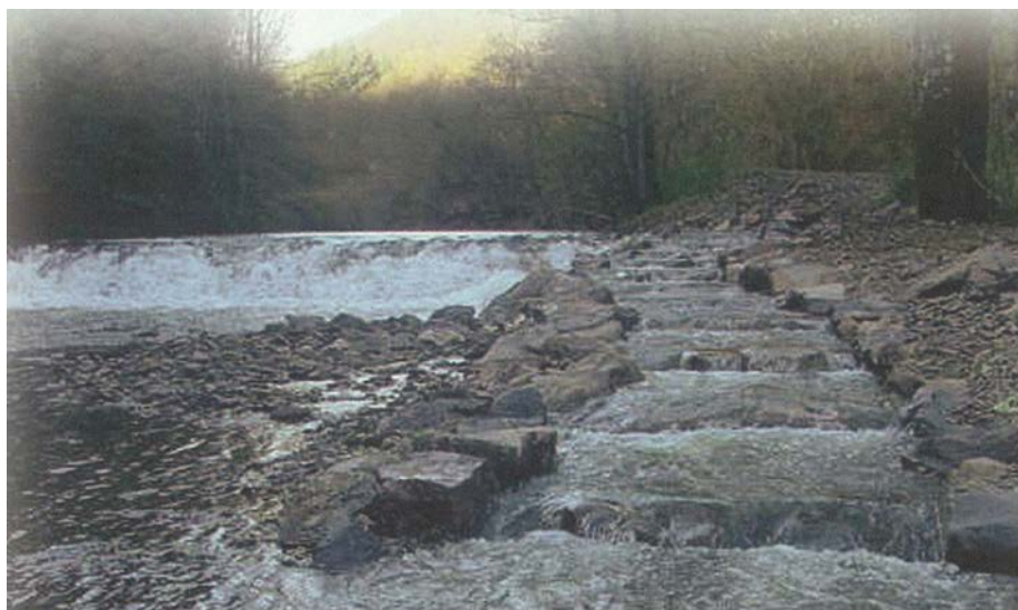
図 7.28 自然石による魚道
