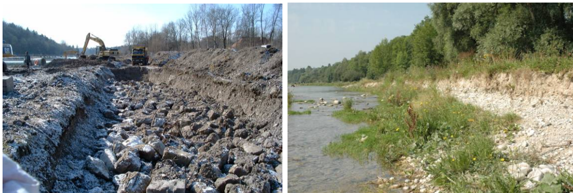
図 6.19 工事状況(左)と洪水後の状況(右)
