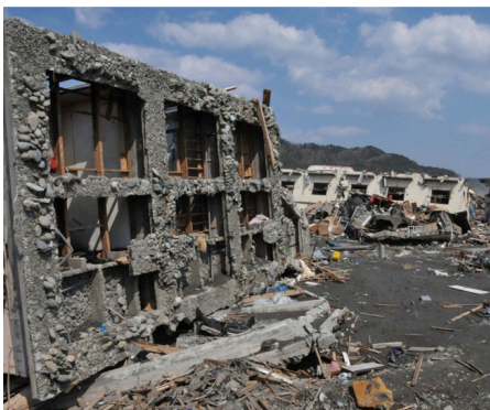
図 17. 新港町の深刻な被害状況
