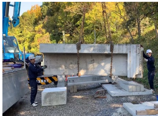
図-6 麦野跨線橋設置状況
