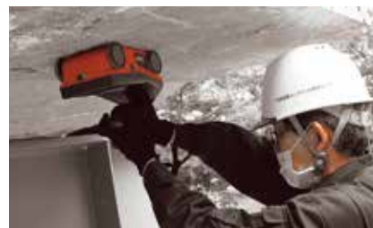
電磁波レーダーによる非破壊検査
