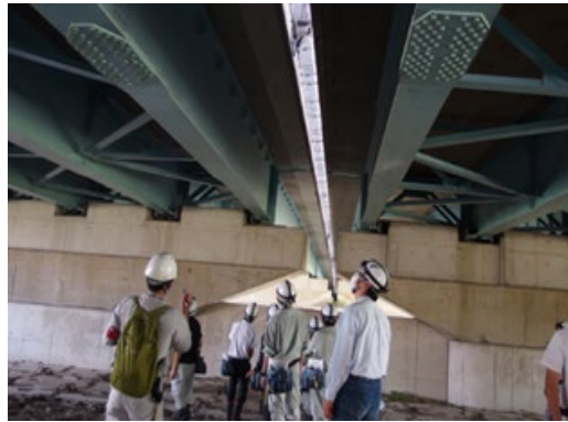
図-2 講習会 (橋梁点検)
