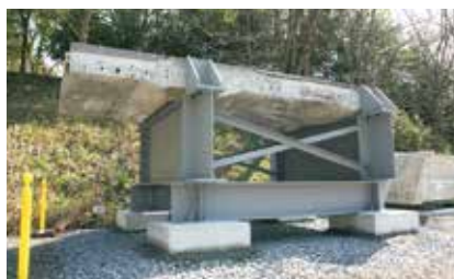
鉄筋コンクリート床版
