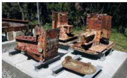
鋼トラス橋・支承
