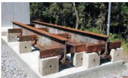
鋼リベット桁
