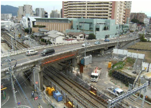
図-5 麦野跨線橋供用時
