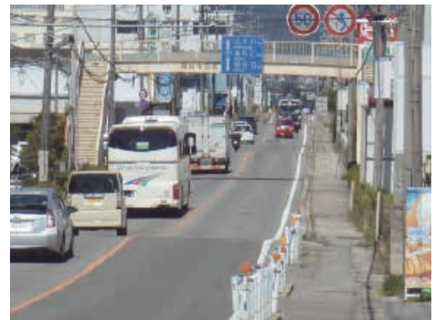
写真-2 地盤沈下が著しい国道20号線（諏訪市四賀）
