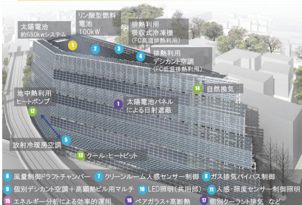
図3 東京工業大学 環境エネルギーイノベーション棟のエネルギー設備の概要
