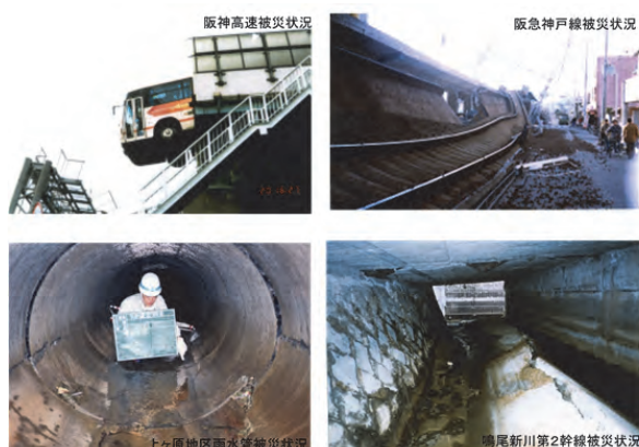
阪神・淡路大震災での下水道施設被災状況
