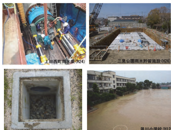
浸水対策の施工事例
