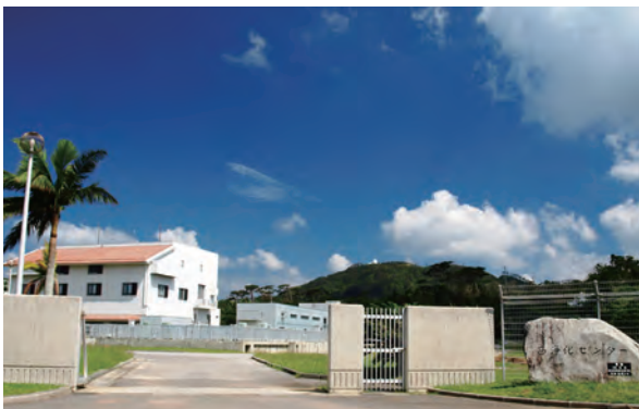
西浄化センターと奥手に見える石垣島天文台
