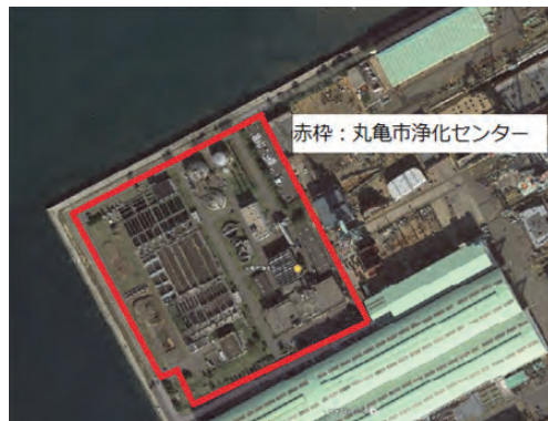
写真-2 改築更新計画中の丸亀市浄化センター
