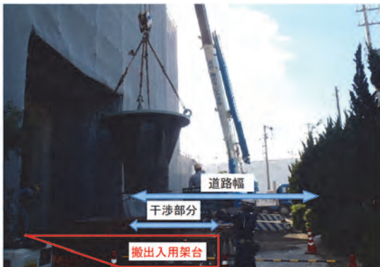
写真3 搬出入用架台による作業状況
