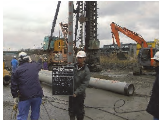
参考写真2：杭施工の立会確認をしている「JS 監督員」と「工事監理者」
