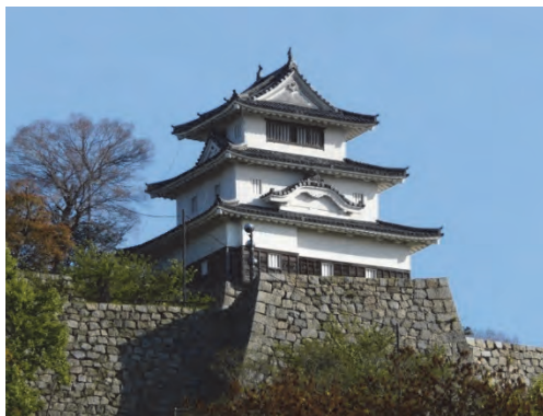
写真-1 現存十二天守閣の一つとして有名な丸亀城
