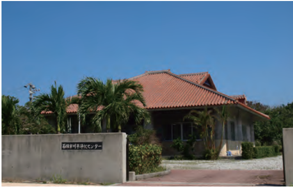
石垣の青空に映える琉球瓦の川平浄化センター
