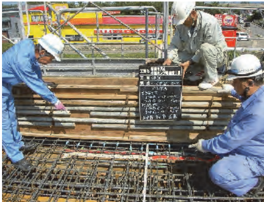
参考写真1：「JS 監督員」と「工事監理者」二人体制による配筋検査状況
