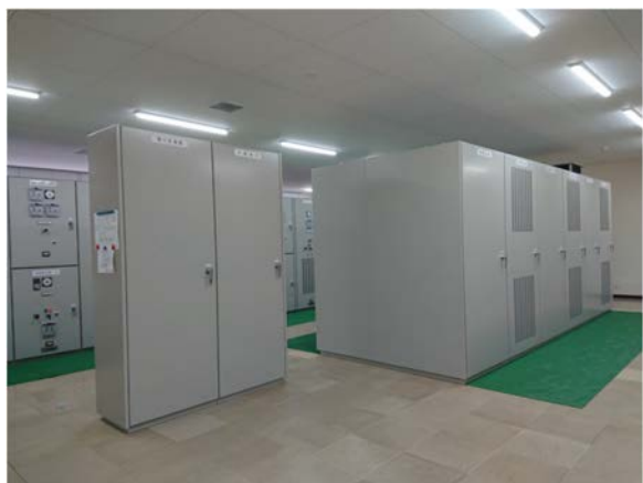
写真 4：新たな電気室は 2 階へ
