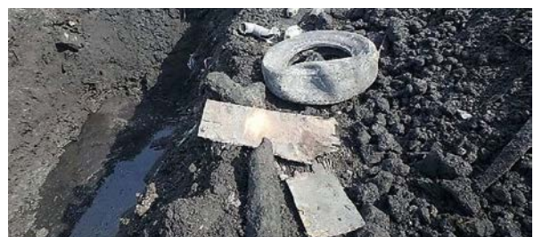
写真-1 産業廃棄物混入状況
