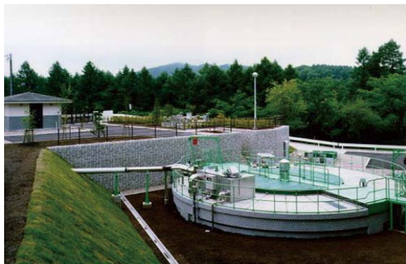
写真 2 POD 施設の全景
