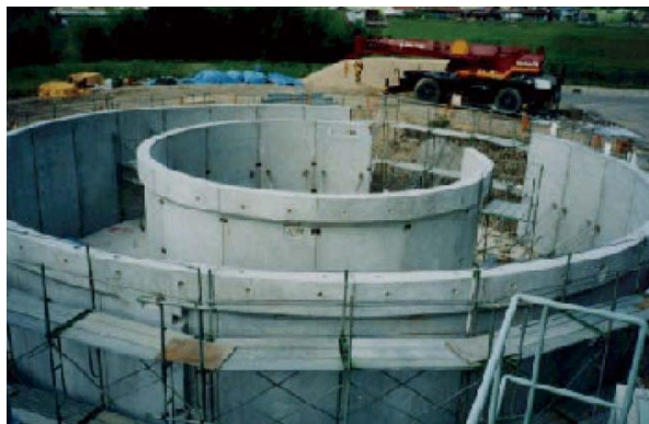
写真 1 POD 施設の建設状況
