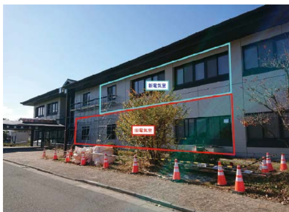
写真 2：浸水した 1 階電気室を 2 階へ計画し施工
