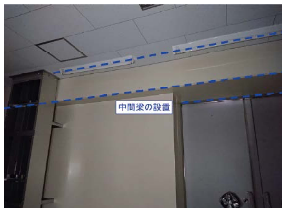
写真 6：放流ポンプ棟電気室の耐水化対策(中間梁設置)
