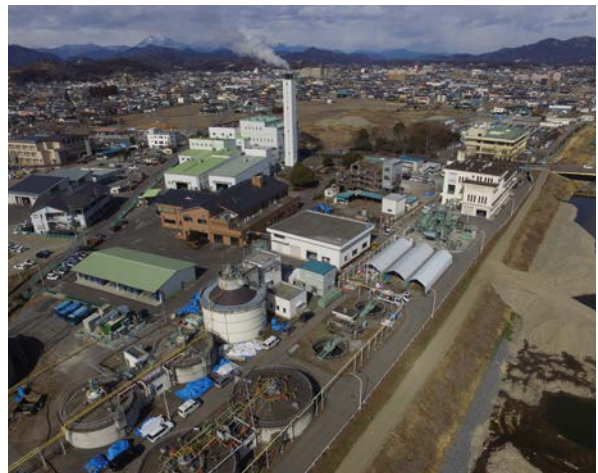
黒川終末処理場（ガス発電施設、B-DASH施設）
