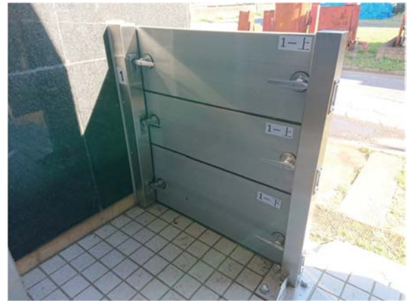
写真 8：防水板（整理番号を貼り管理をし易くした事例）
