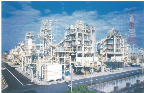
大阪北東エースセンター(溶融炉全景)
