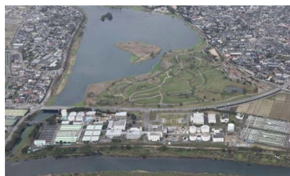
図4 東部浄化センター全景（着工前）
