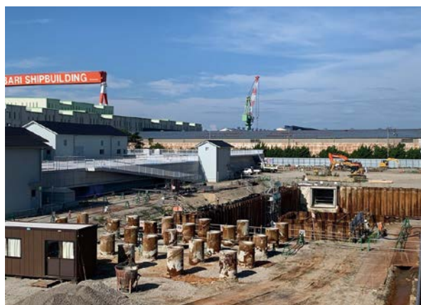
写真－2 工事進捗状況（令和3年10月現在）
