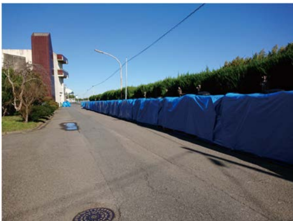
写真 7：処理場施設に大型土嚢で対応（短期の対策）
