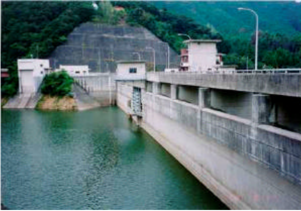
写真-9 賀祥ダム右岸から左岸を望む
