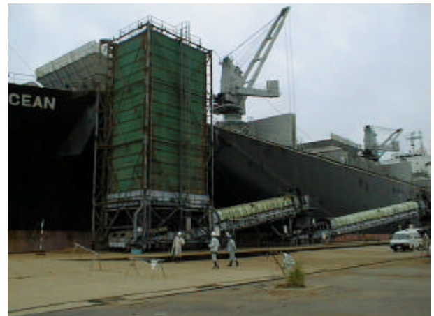
写真-10 昭和南-13m岸壁における被害 (ケーソン背後に段差が生じた。チップアンローダーは地震後も正常に動作した)
