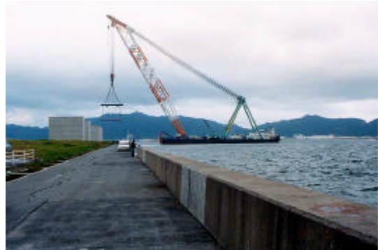
附-8 護岸の被害 (境港市竹内工業団地) 護岸背後の亀裂、奥に見えるのはケーソールド
