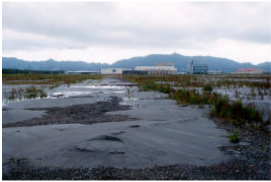
附-1 液状化による噴砂 (境港市竹内工業団地)
