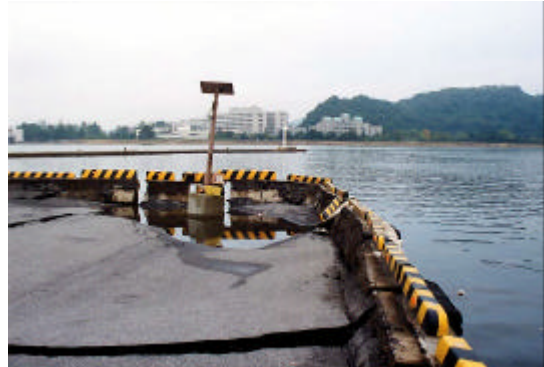
附-24 護岸の被害 (米子市米子港) コーナー部における吸出し
