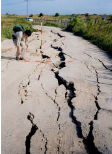
附-13 道路の被害 (松江市大海崎堤防道路) 液状化による亀裂 <提供：清水建設(株)福武氏>
