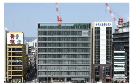
写真1：改修前後の外観
