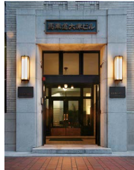
馬車道大津ビルのエントランス
